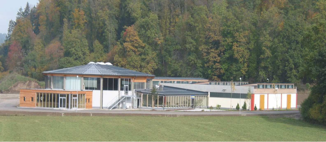
Versteigerungshalle St. Donat in Kärnten
