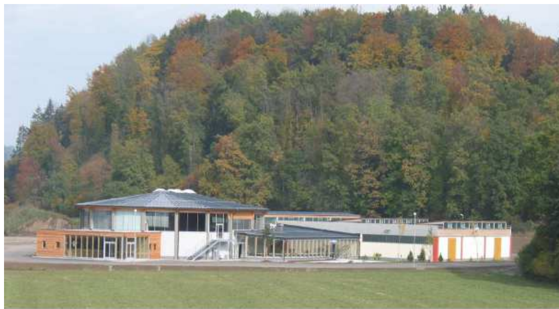
Versteigerungshalle St. Donat in Kärnten
